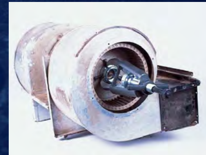
Blower fan removal
